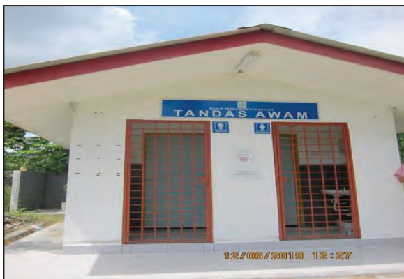
Kolam Air Panas Batu 16, Dusun Tua -Tandas Awam yang Tidak Digunakan (02.07.2019) (Sumber: Jabatan Audit Negara)
