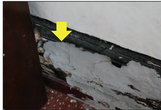
Rumah Rehat Seri Berkas - Papan Skirting Dimakan Anai-anai (Sumber: TSSB)
